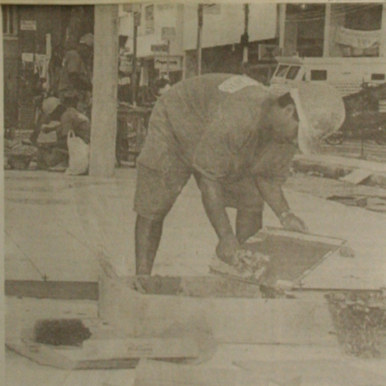
No Centro, homens trabalham no assentamento do novo piso dos calçadões
