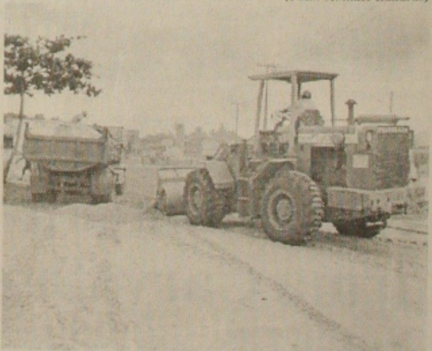
Máquinas e caçambas executam pavimentação
