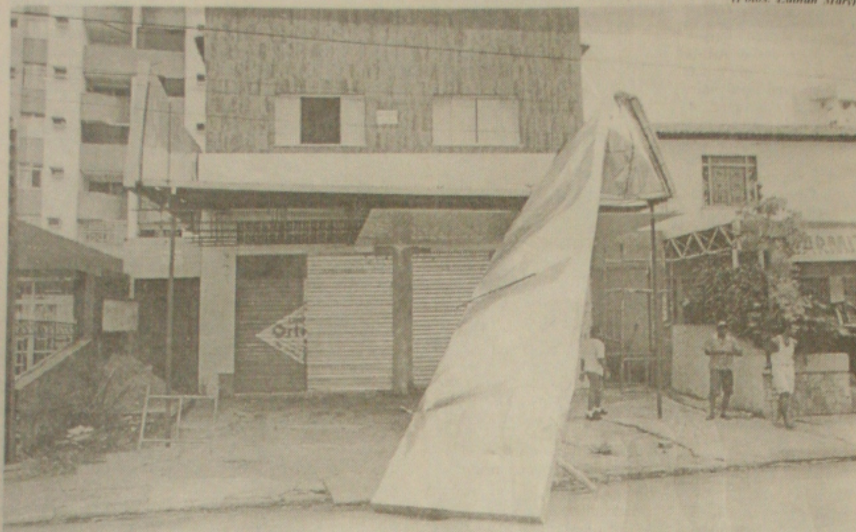
Luminoso de zinco não resistiu a ventania e caiu
