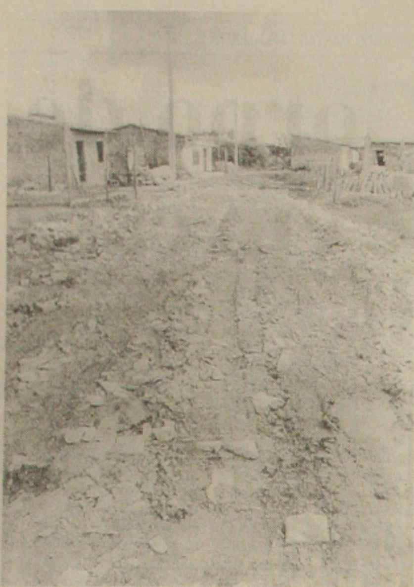
Aterro estava sendo feito com restos de gesso
