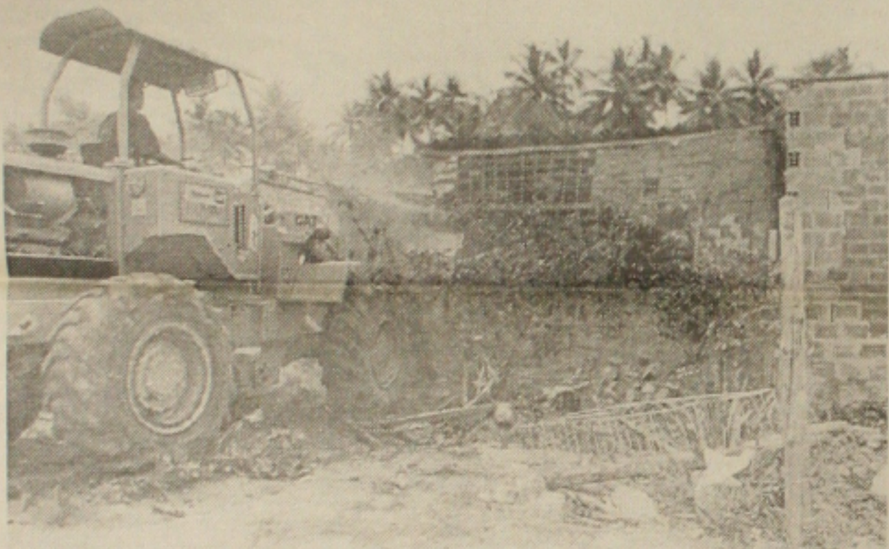
Trator derruba casebres à beira do Canal Santa Maria
