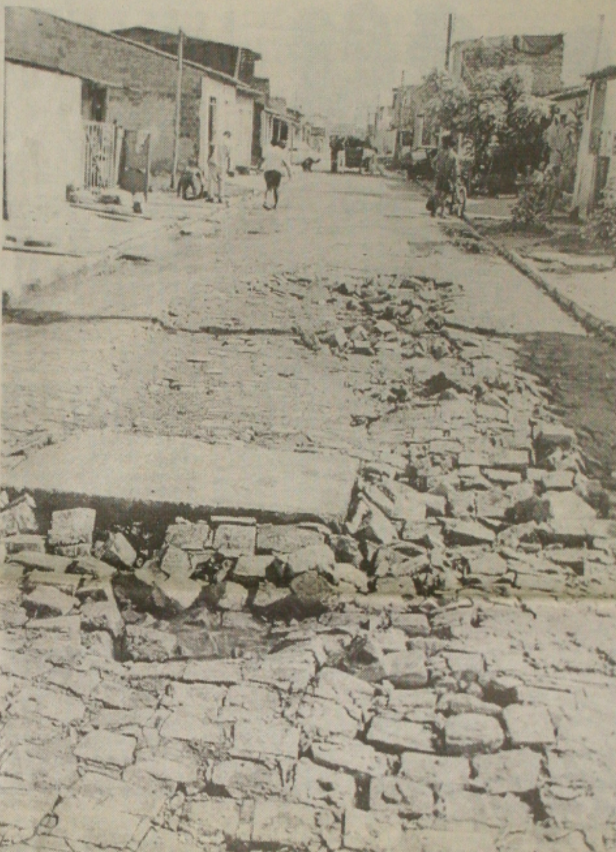
Em várias ruas do bairro, a pavimentação, a paralelepípedo, acabou cedendo com as chuvas
