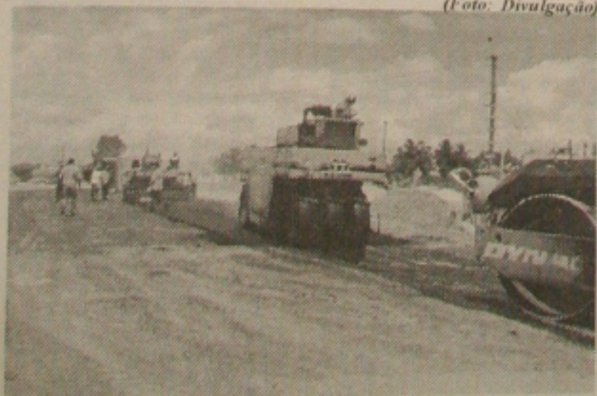
Novo terminal começa a ser pavimentado
