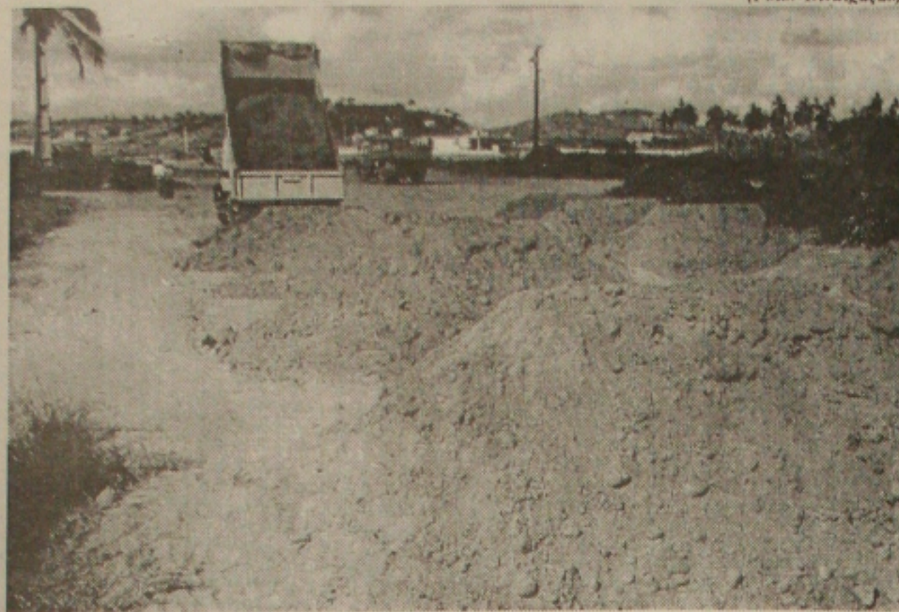
A estrada de acesso ao Conjunto Orlando Dantas, na zona sul da capital, recebe pavimentação
