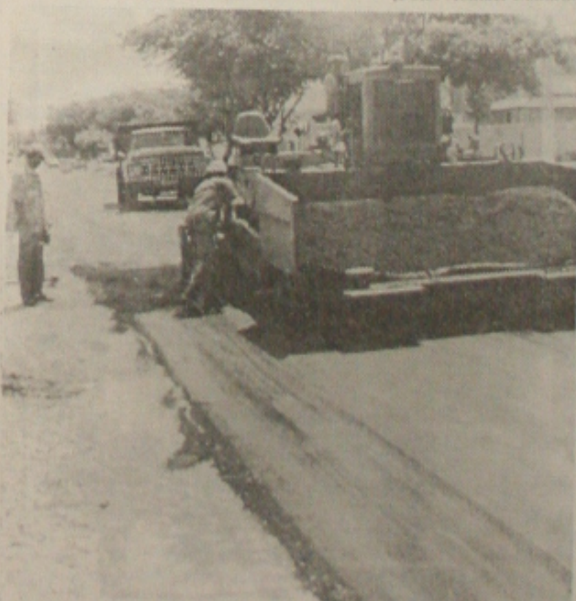
Recapeamento asfáltico no JK e Sol Nascente
