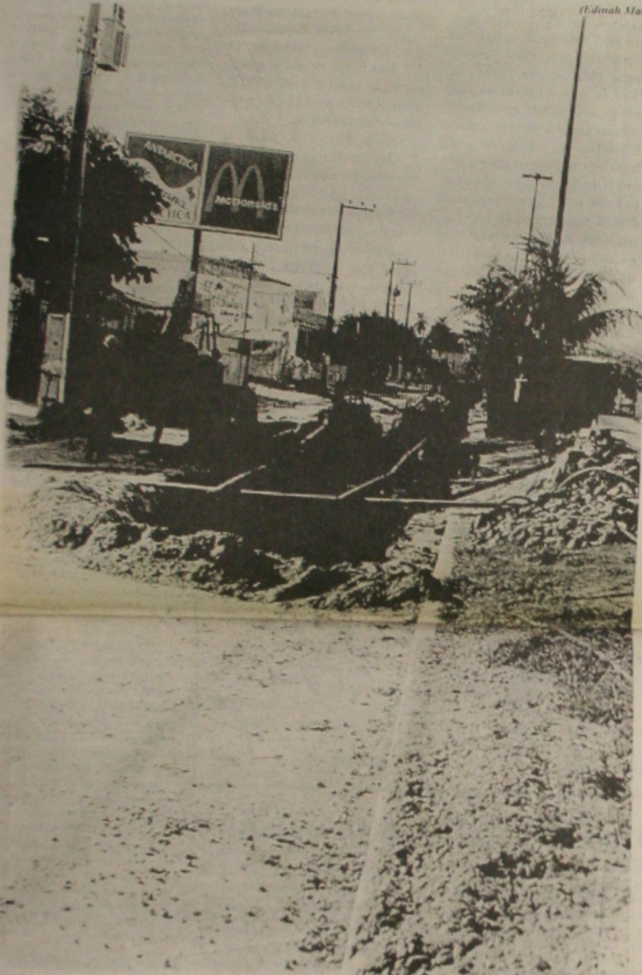
As chuvas fora de época, segundo o Deso, acabaram atrasando a conclusão das obras na avenida
