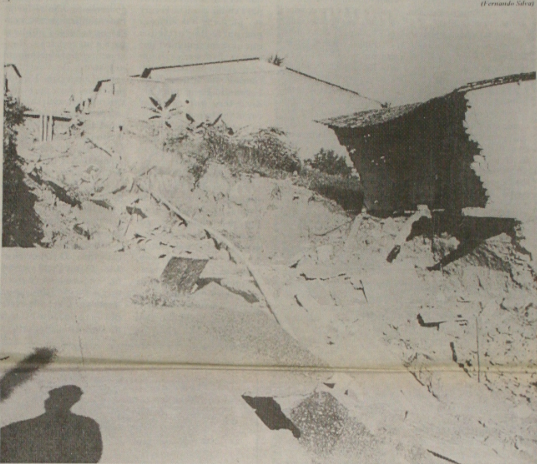
Na Rua João Bebe Agua, três casas já desabaram e o calçamento afundou por causa de infiltrações
