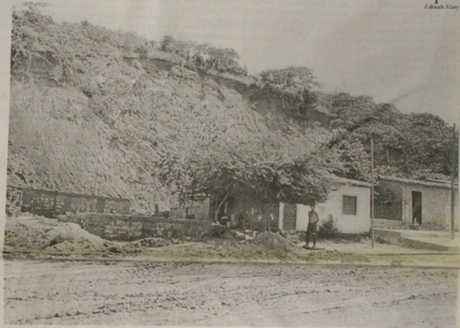
Na Avenida Euclides Figueiredo, os deslizamentos de terra são constantes durante os períodos chuvosos
