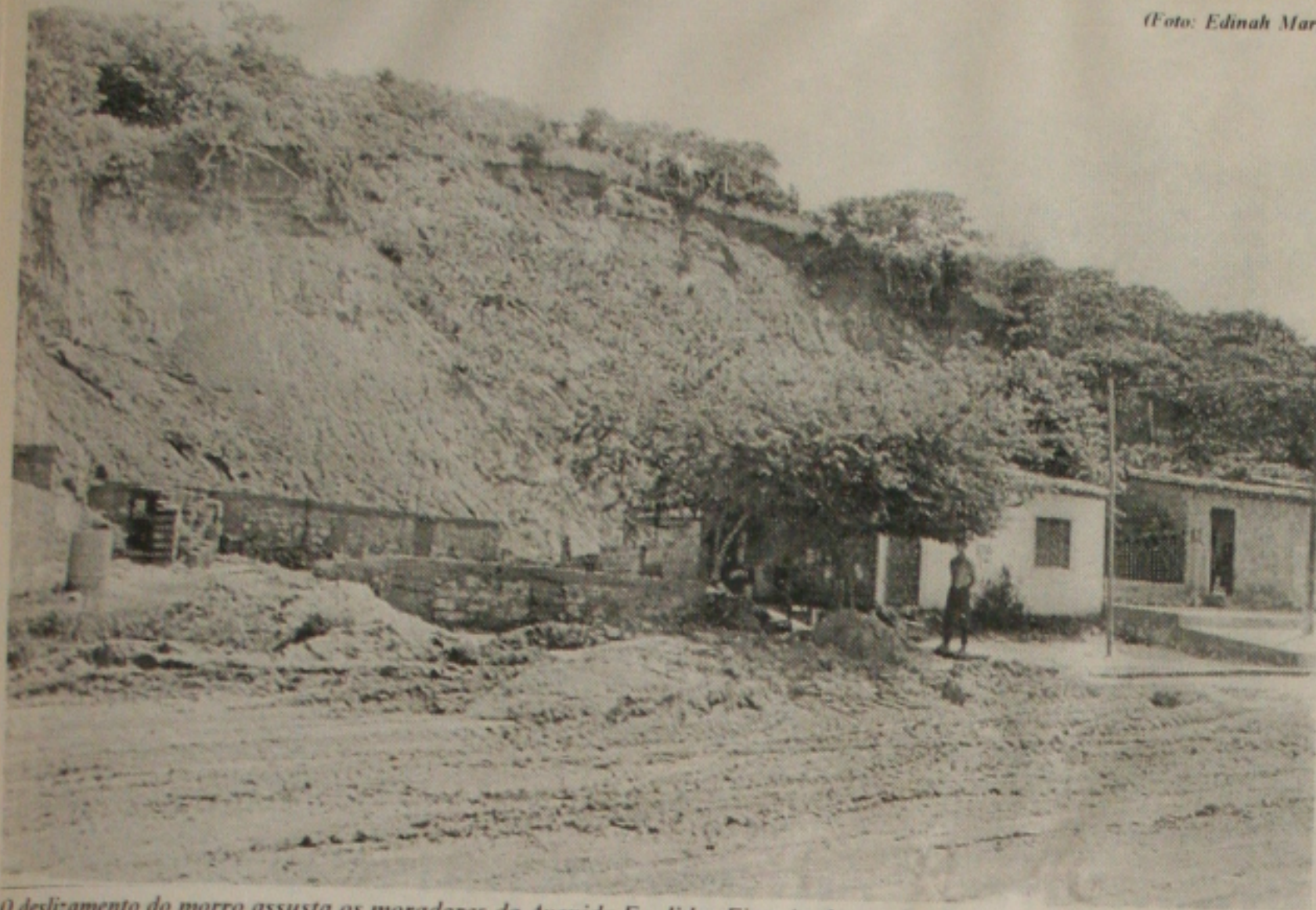
O deslizamento do morro assusta os moradores da Avenida Euclides Figueiredo, trecho do Bairro Industrial
