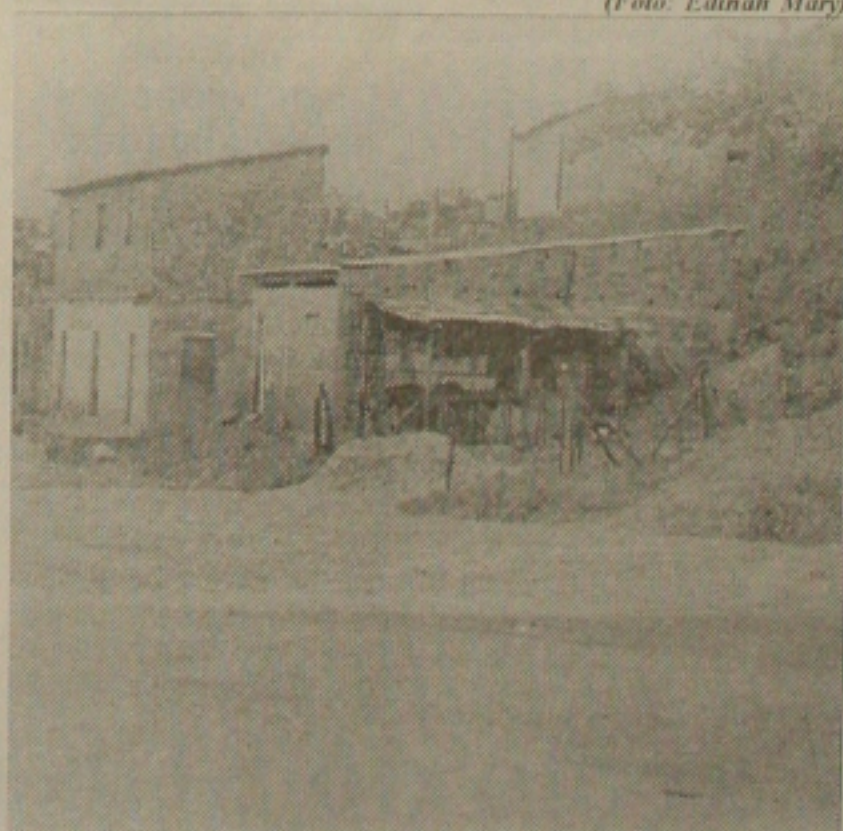
O deslizamento do morro do Urubu é por causa desmatamento
