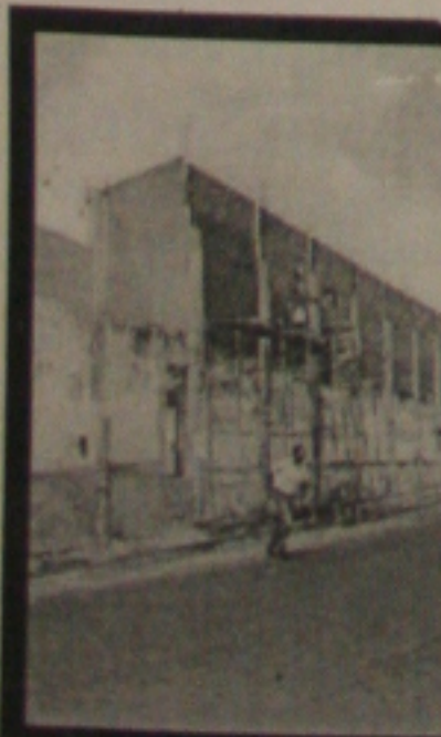
Domingo o torcedor do Confiança terá um reencontro com o velho estádio Sabino Ribeiro (foto). O estádio passa por completa reforma, para oferecer mais conforto e segurança. Do gramado às cabines de rádio, as mudanças serão notadas. As obras, gerenciadas pelo conselheiro Rubens Chaves não estarão concluídas até domingo. No entanto, o torcedor vai sentir de cara as modificações. No projeto consta inclusive, um novo sistema de iluminação.
