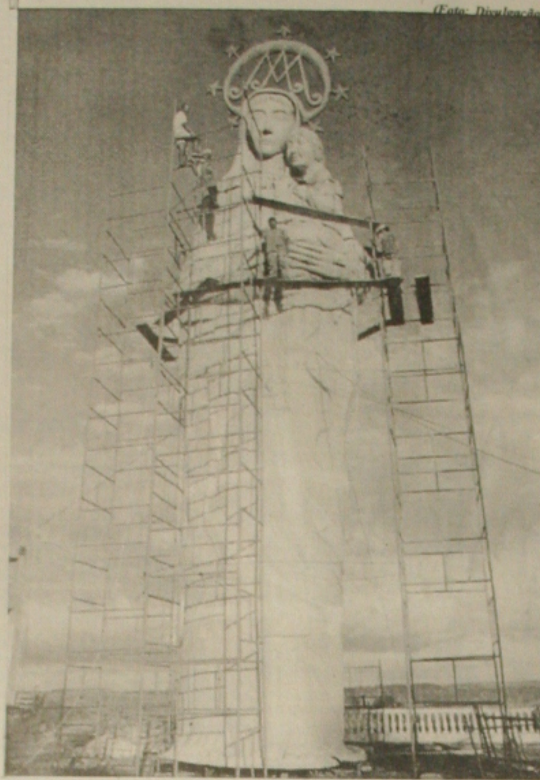
Uma equipe de quatro homens trabalhou na montagem do monumento
