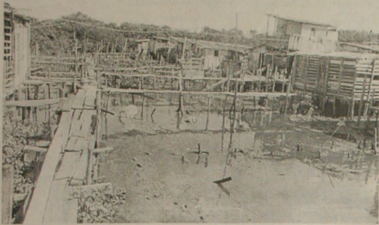
A construção de palafitas contribuiu para a devastação do manguezal no Bairro Coroa do Meio
