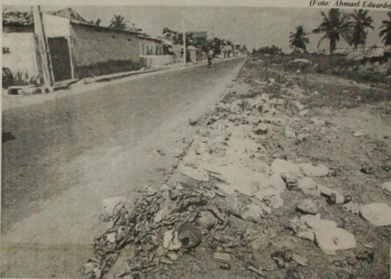
Comunidade transforma rua em lixeira a céu aberto depois das obras de melhorias feitas pela Emurb
