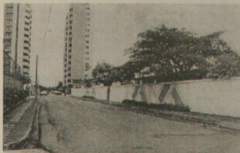
Loteamento Garcia: pavimentação em fase de conclusão
