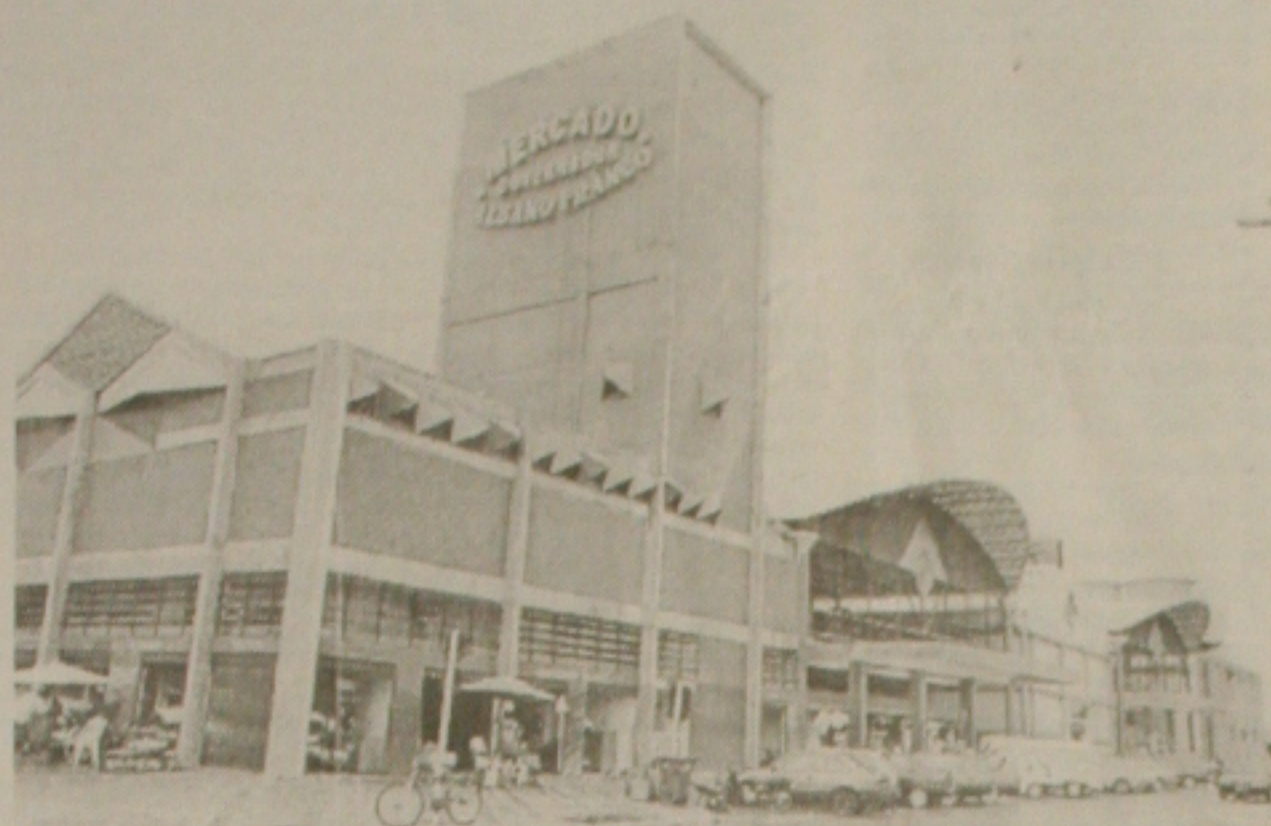
Piso do Mercado Albano Franco será concluído pela Celi
