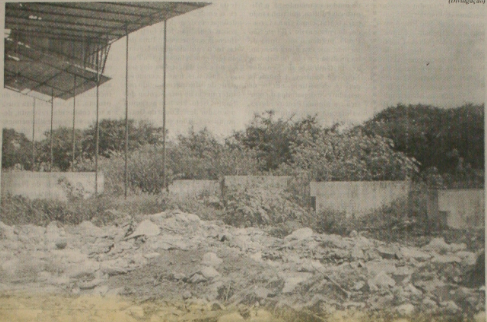
O local onde a usina deveria ser instalada virou um lixão, cercado de mato por todos os lados
