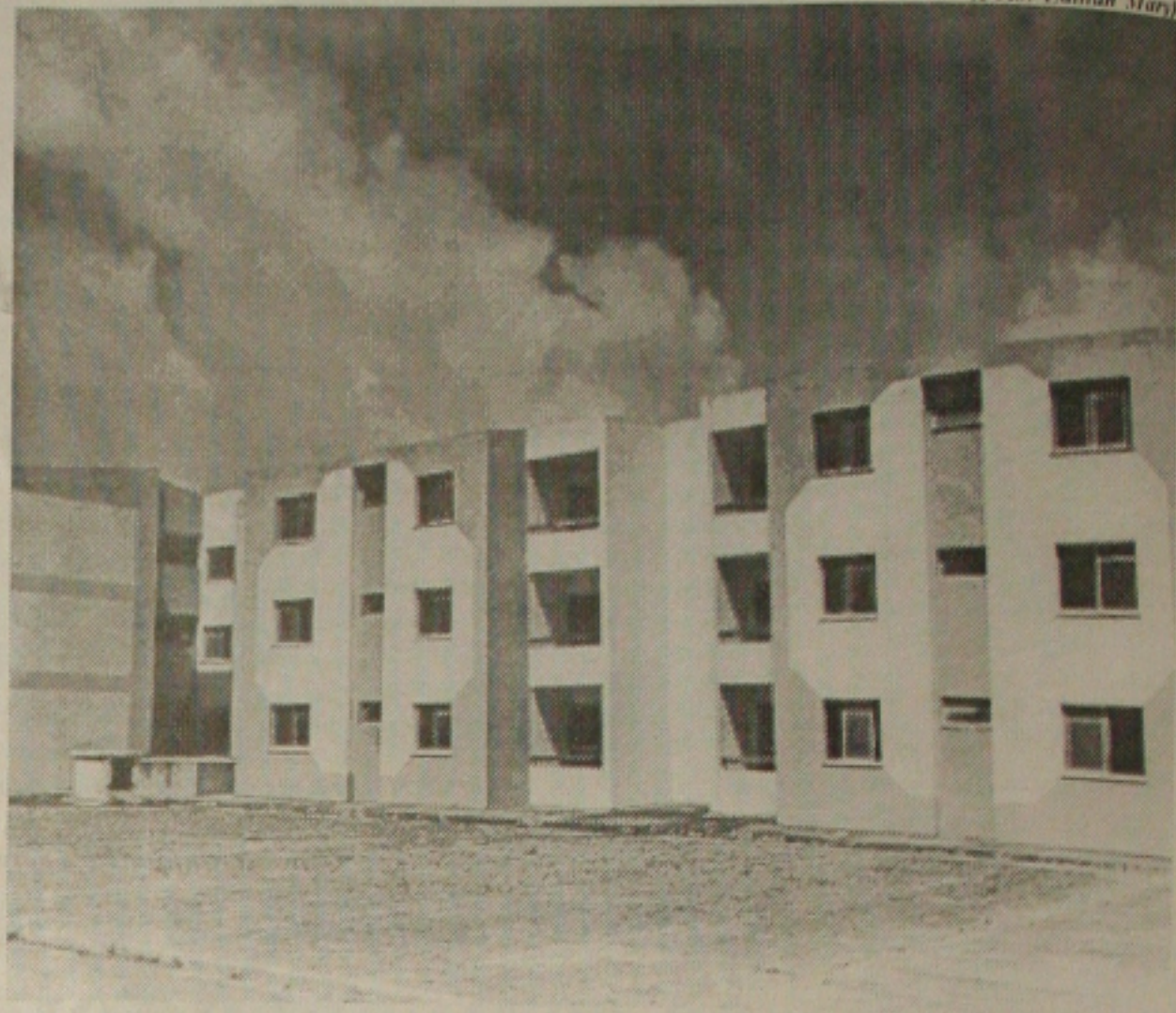
Moradias não têm "brigadas" de incêndio e nem equipamentos
