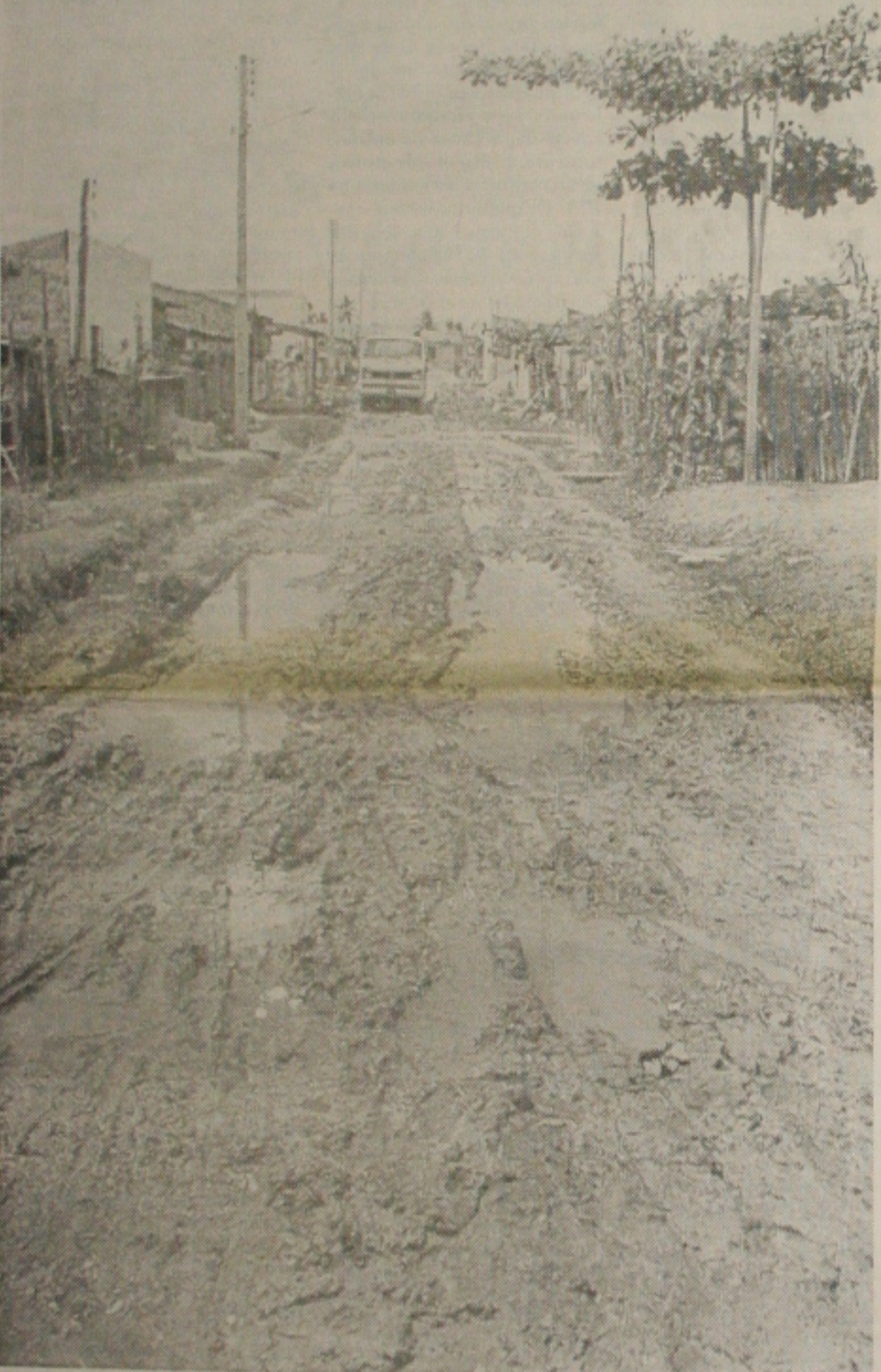
Com as chuvas, as ruas do loteamento, sem pavimentação, ficam totalmente intransitáveis
