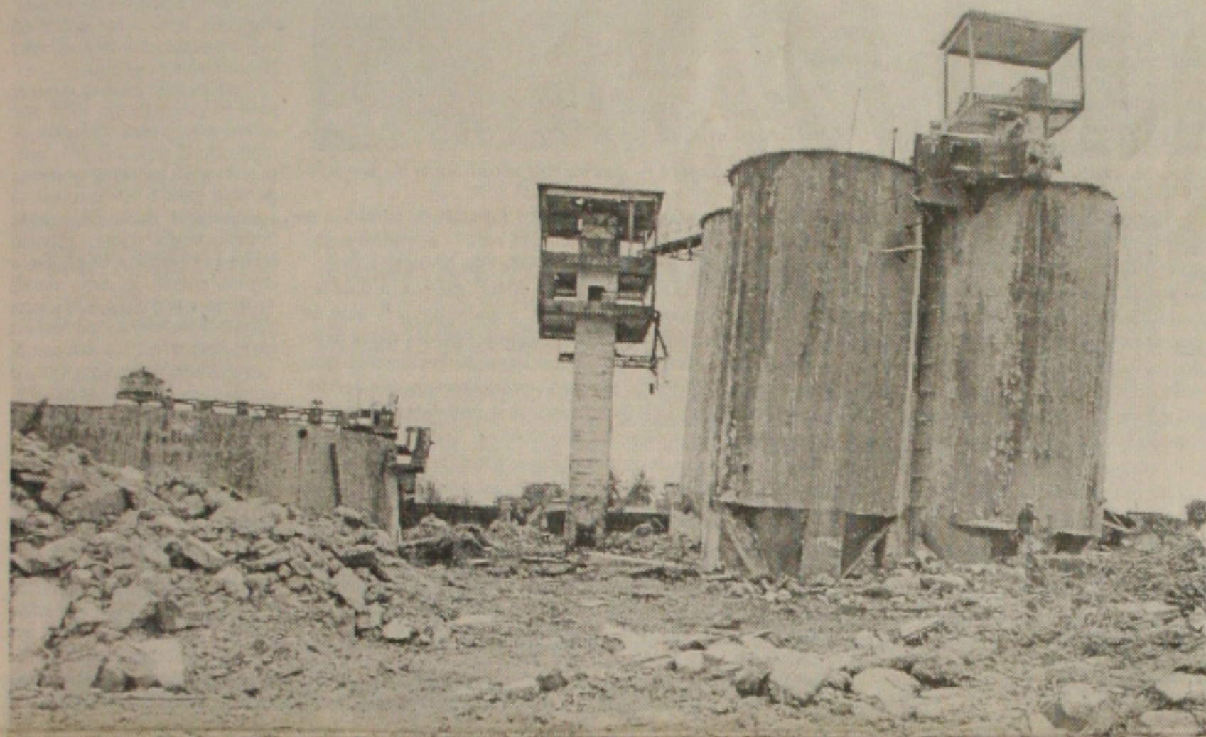
Implosão de antiga fábrica de cimento no Siqueira Campos causa prejuízo e revolta aos moradores
