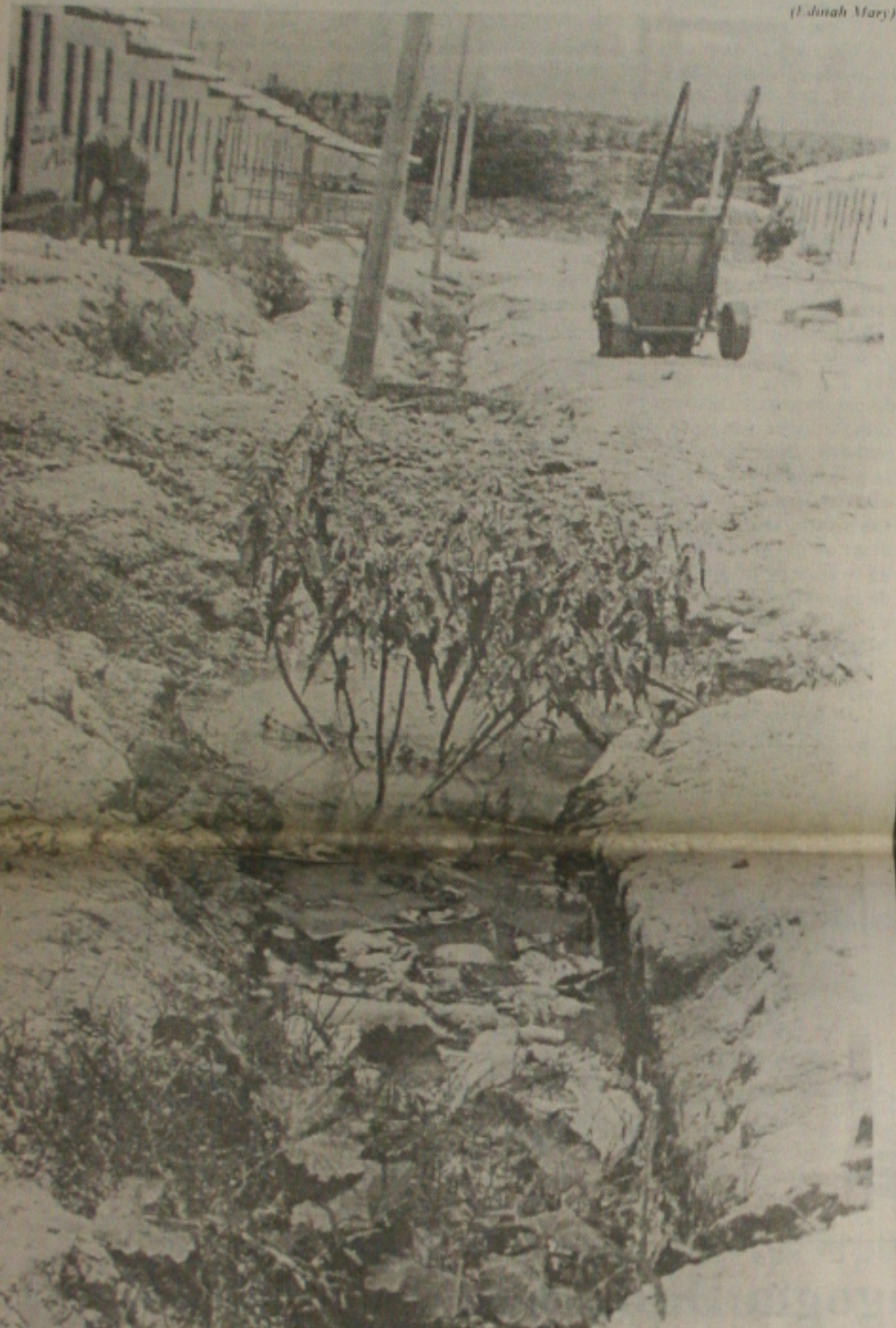
As ruas do conjunto estão comprometidas pela erosão, colocando em risco casas e moradores (Agência Sergipe)
