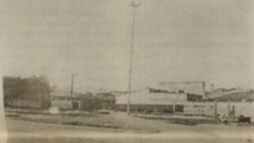
As obras da praça do Conjunto Costa e Silva em fase final
