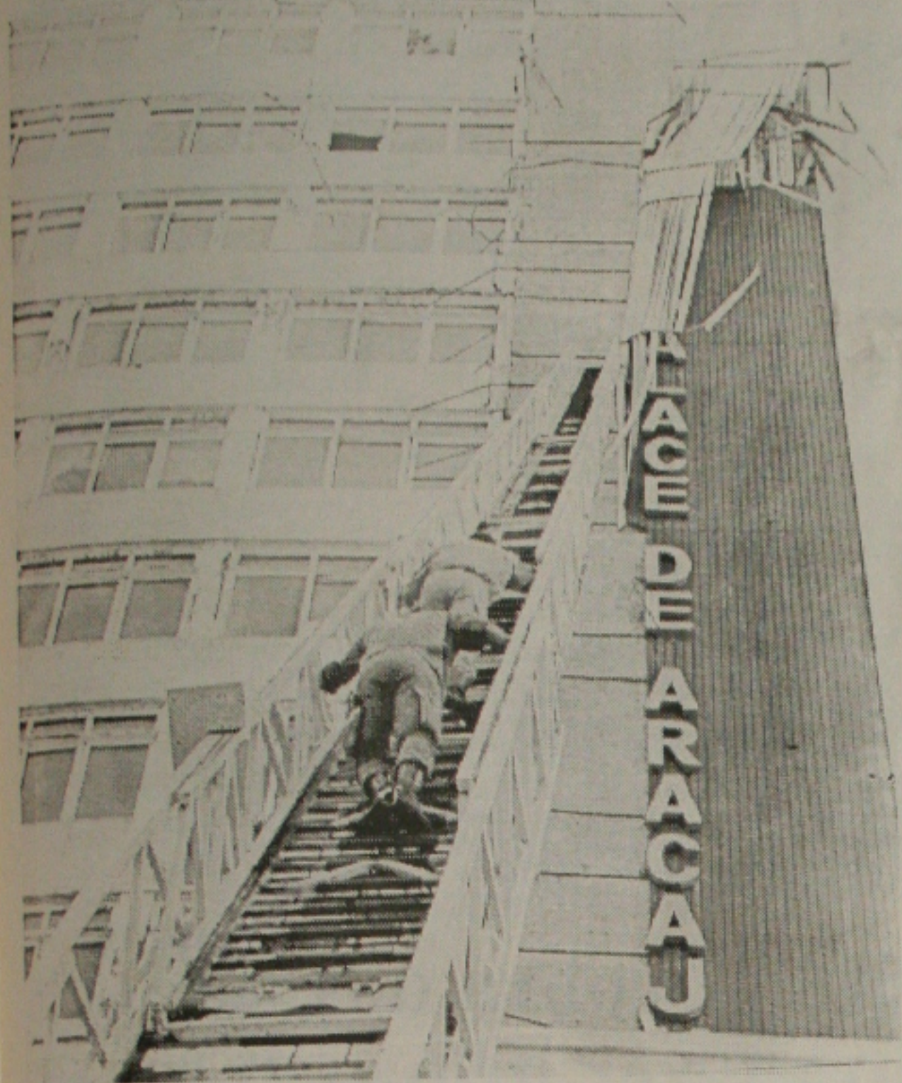
Bombeiros usam escada magirus para retirar parte da cobertura de alumínio que desabou no prédio
