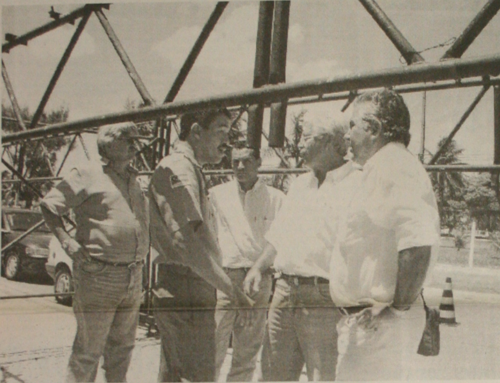
Os técnicos da Defesa Civil voltaram ontem ao corredor da folia para vistoriar a montagem dos camarotes
