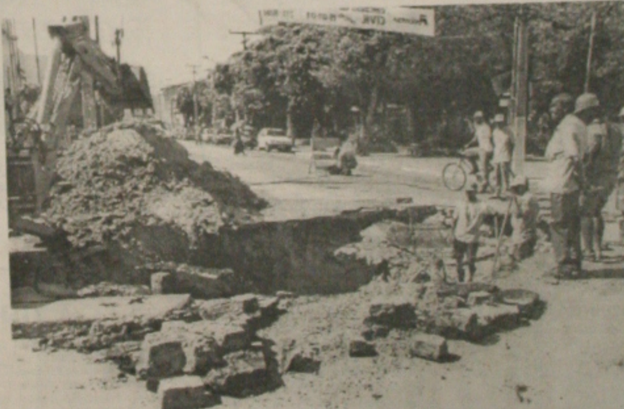
Depois do acidente com o carro do médico, funcionários do Deso começaram a trabalhar no local
