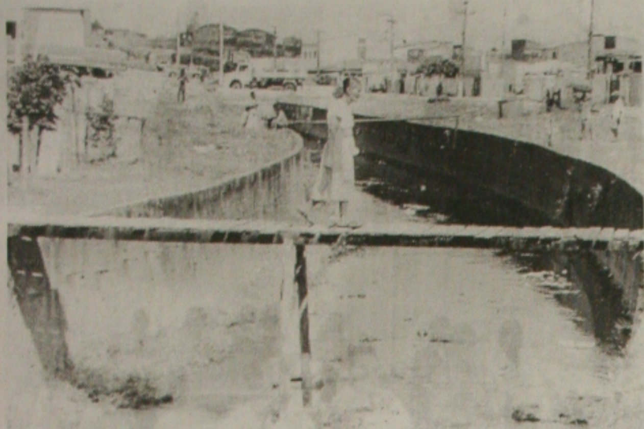
A ponte de madeira sobre o canal do bairro tem sido uma grande ameaça para os moradores...
