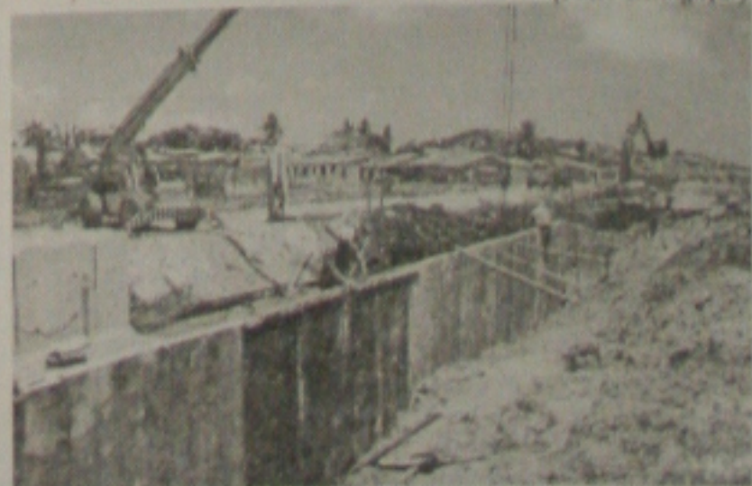
Emurb reveste canal do Almirante Tamandaré
