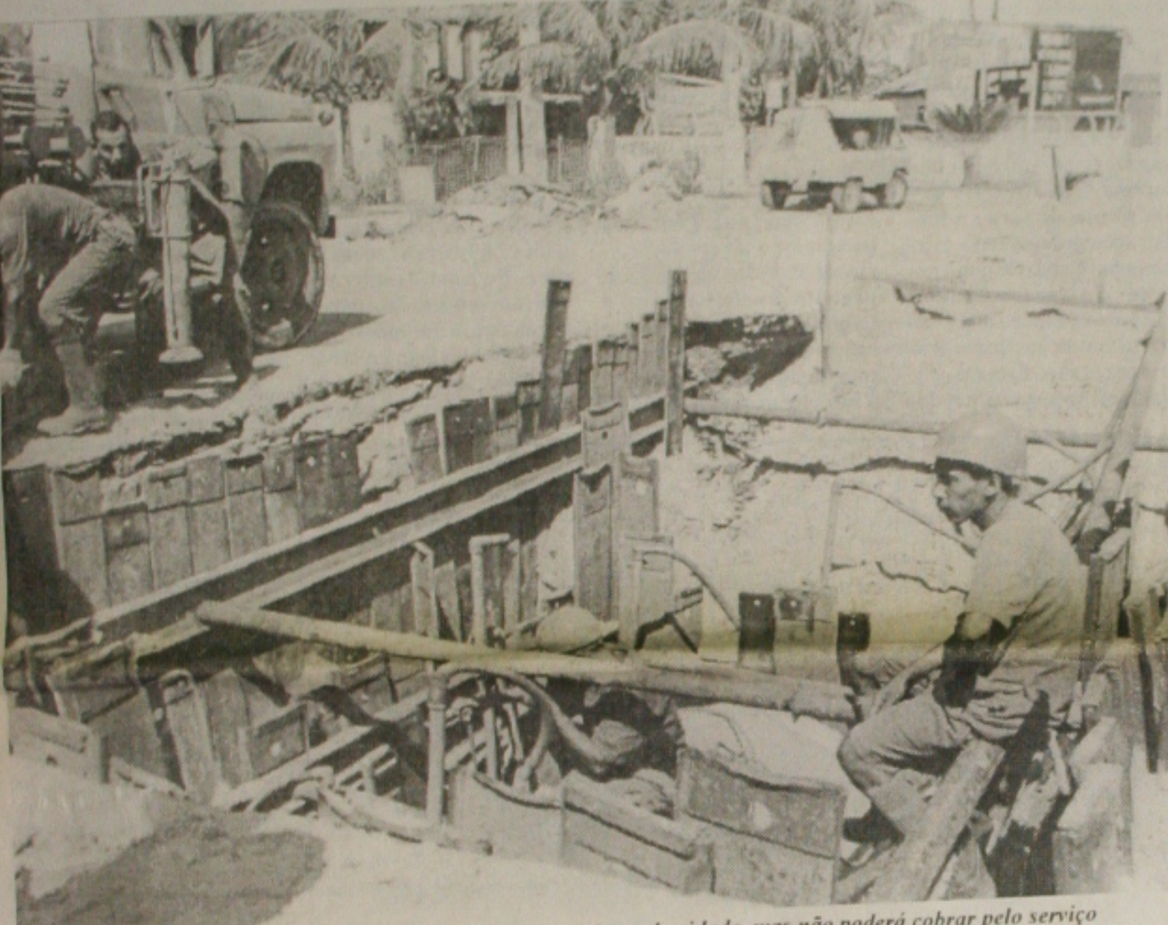
A Deso ainda está montando a rede de esgotos em alguns bairros da cidade, mas não poderá cobrar pelo serviço
