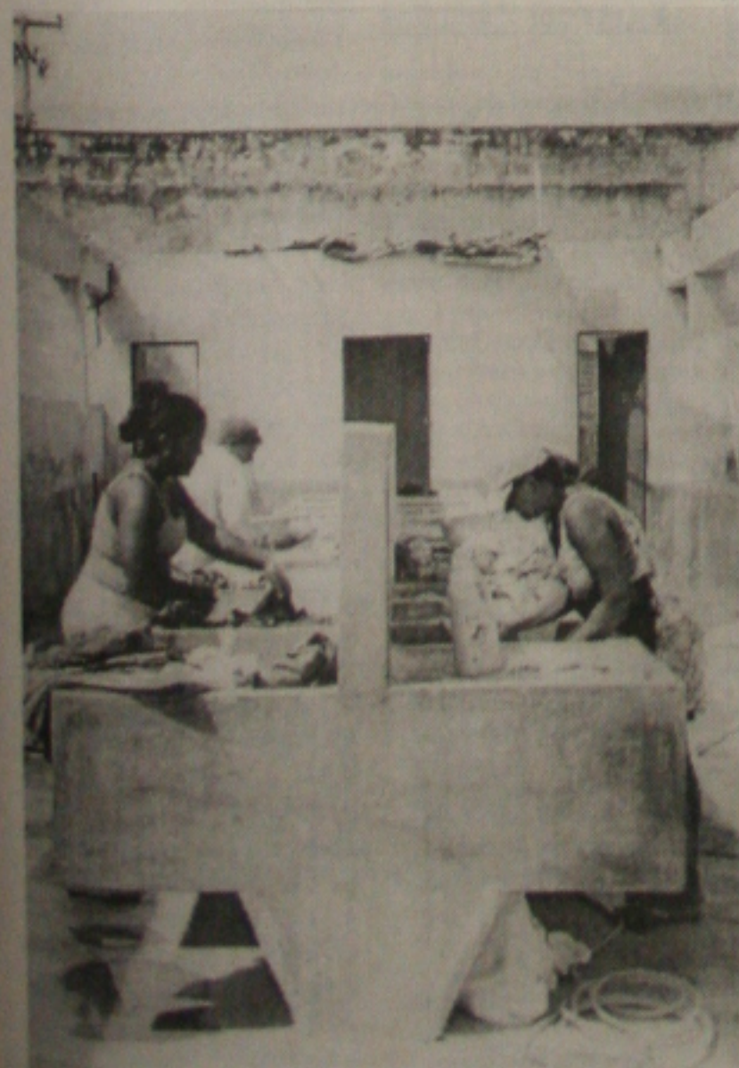
O telhado do logradouro desabou, deixando as lavadeiras expostas ao sol e à chuva
