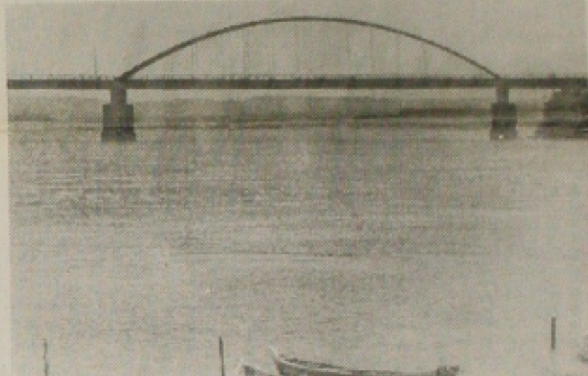
Previstas para começarem em setembro, as obras da transposição do rio devem atrasar
