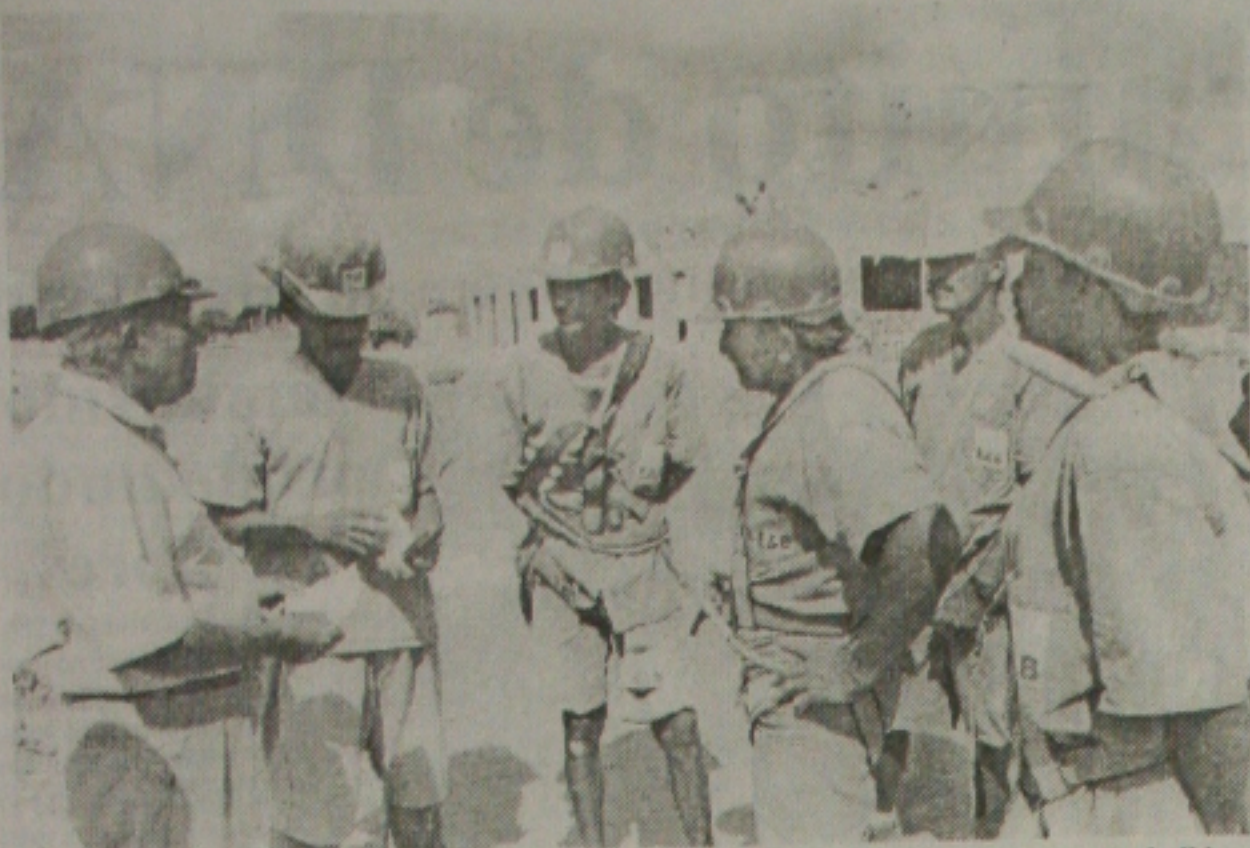
Umbelino reúne-se com os operários no canteiro de obras para explicar os direitos trabalhistas
