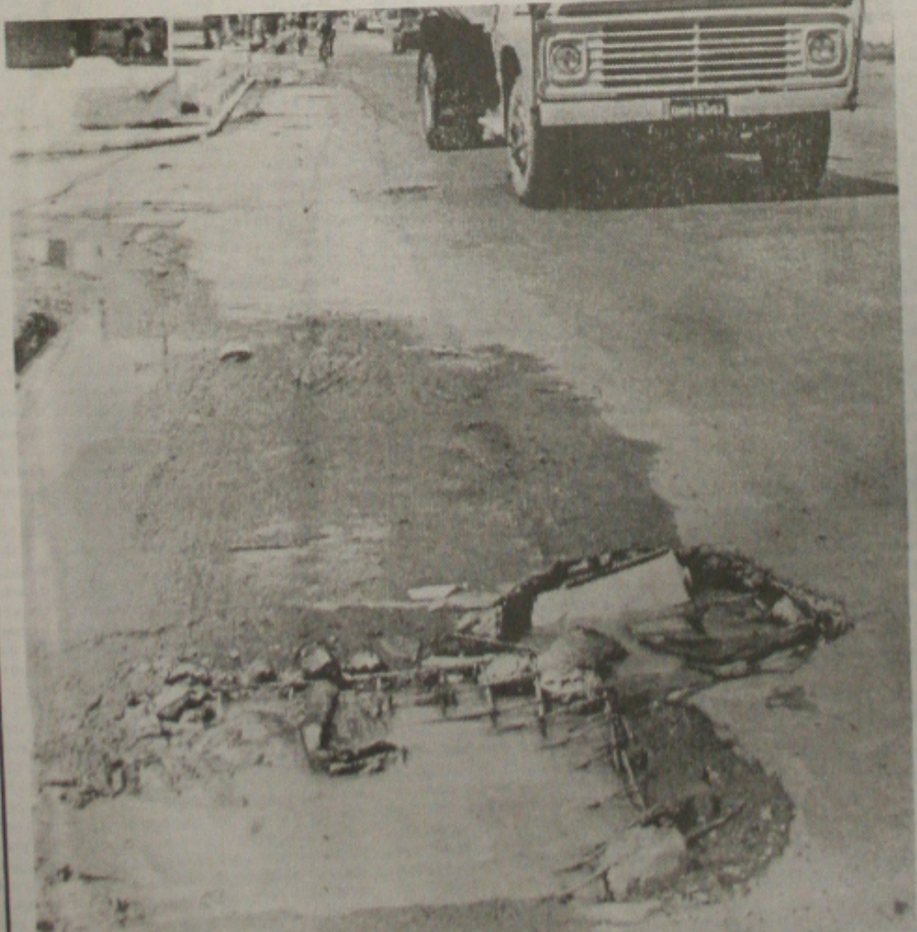
Em algumas ruas, como na Av. Euclides Figueiredo, os buracos surgem sobre a tubulação da rede de esgotos
