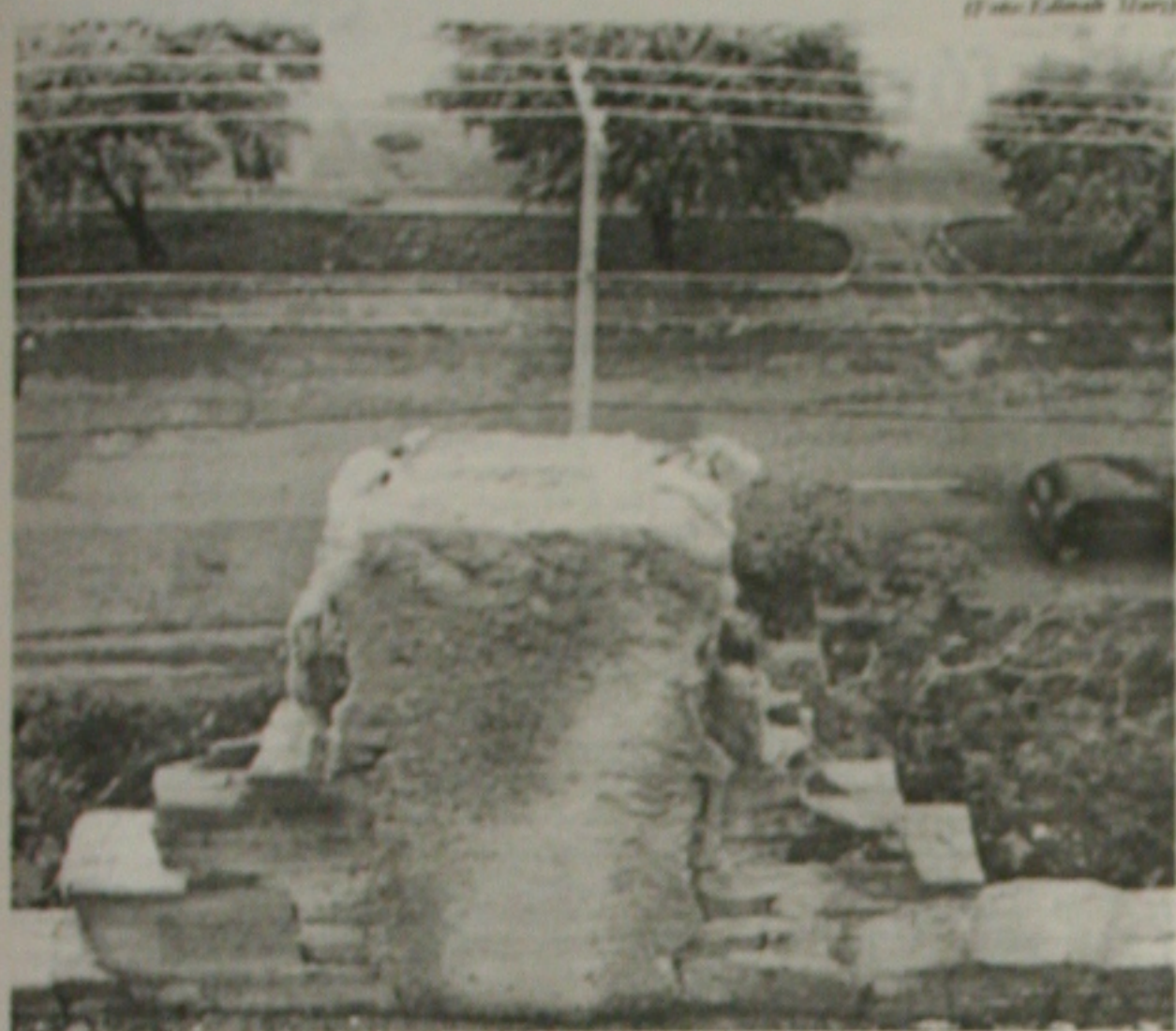
As encostas têm sido uma ameaça para moradores que estão nas chamadas áreas de risco
