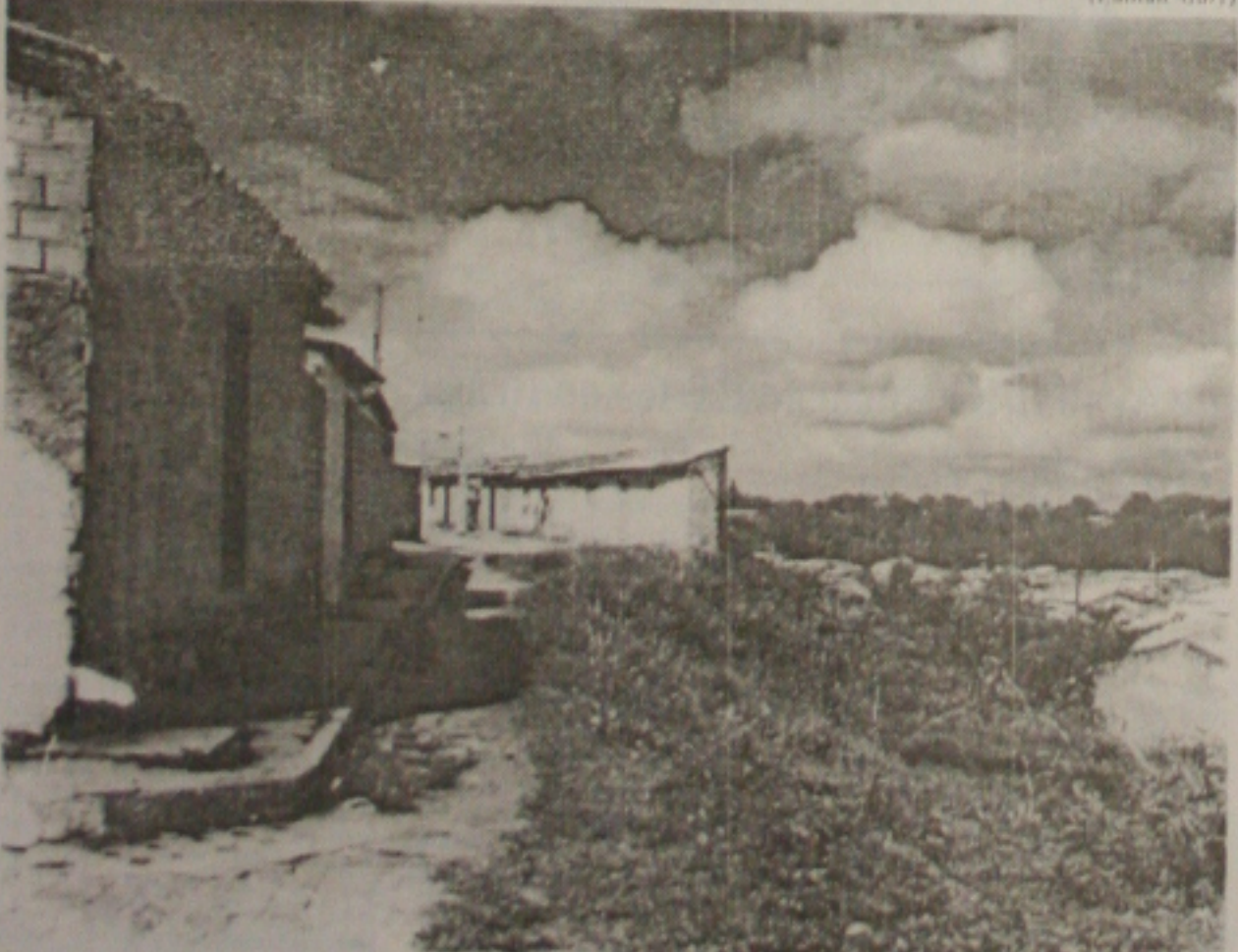
Depois de muitas reclamações, as obras do muro de contenção do Conjunto Maria do Carmo II foram iniciadas pela Cehop. (Página 1B)
