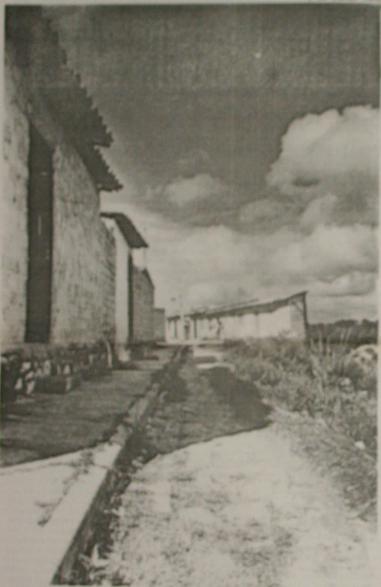
A Cehop retomará as obras de construção do muro de contenção do Conjunto Maria do Carmo II
