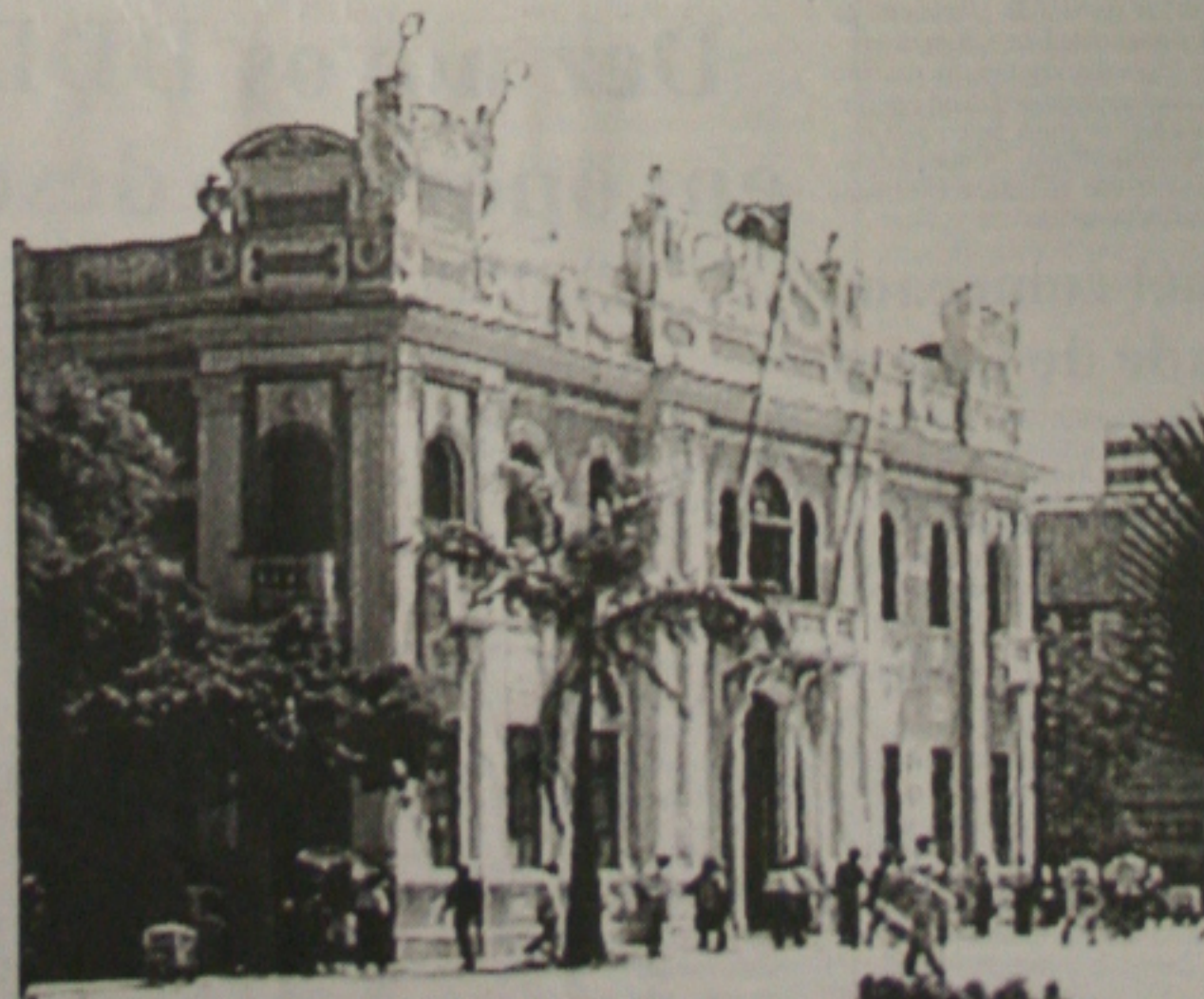
Depois de restaurado, Palácio Olímpio Campos passa a ser pinacoteca do Estado
