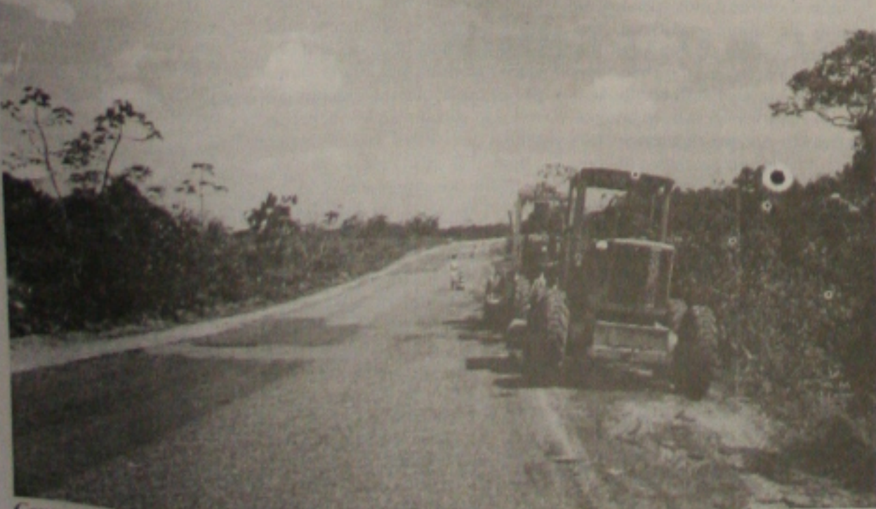
Começam as obras de recapeamento da rodovia de Dorcas. (Página 4-B)
