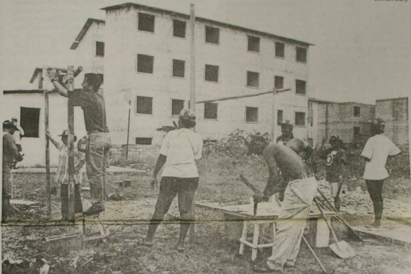
Cerca de 360 famílias invadiram um condomínio em construção no conjunto Augusto Franco, cujas obras estavam paradas
