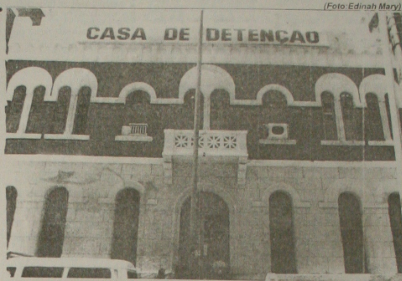
Fuga em massa é registrada na Casa de Detenção do Bairro América
