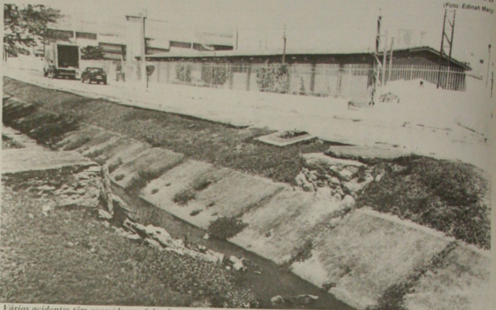
Vários acidentes têm ocorrido por falta de uma ponte sobre o canal da Avenida Caçula Barreto
