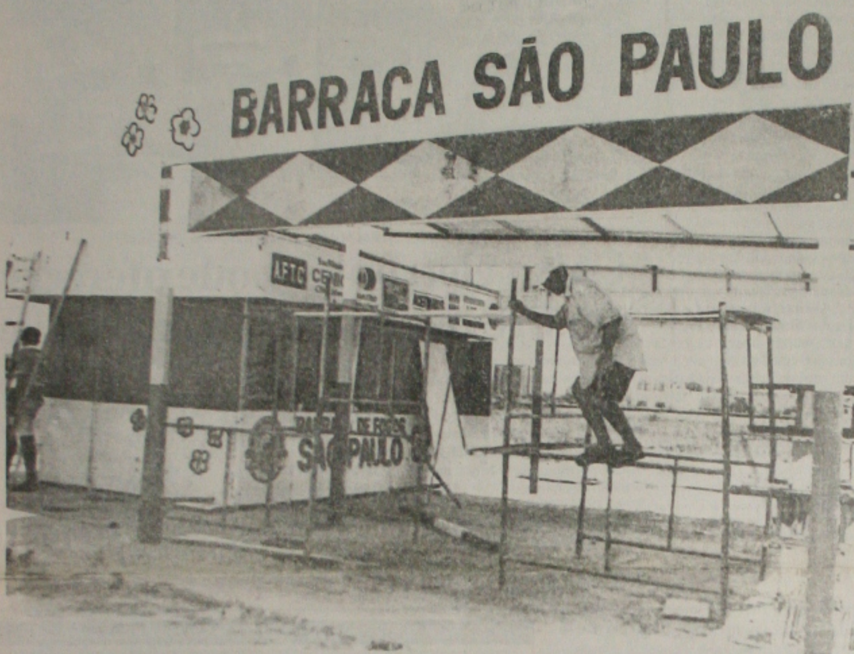
O Corpo de Bombeiros está acompanhando a instalação de barracas para vendas de fogos de artifício
