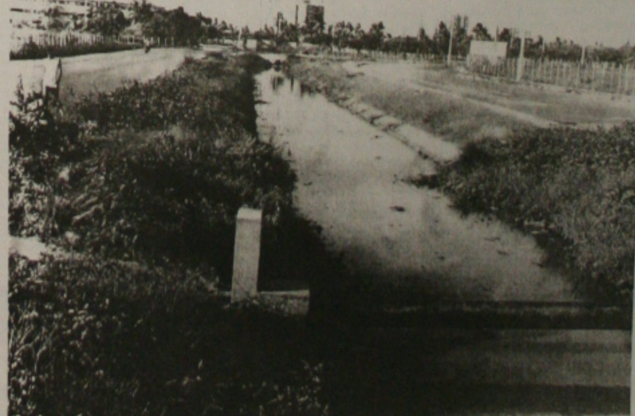
Os canais do Augusto Franco passam por limpeza para evitar inundações no período chuvoso
