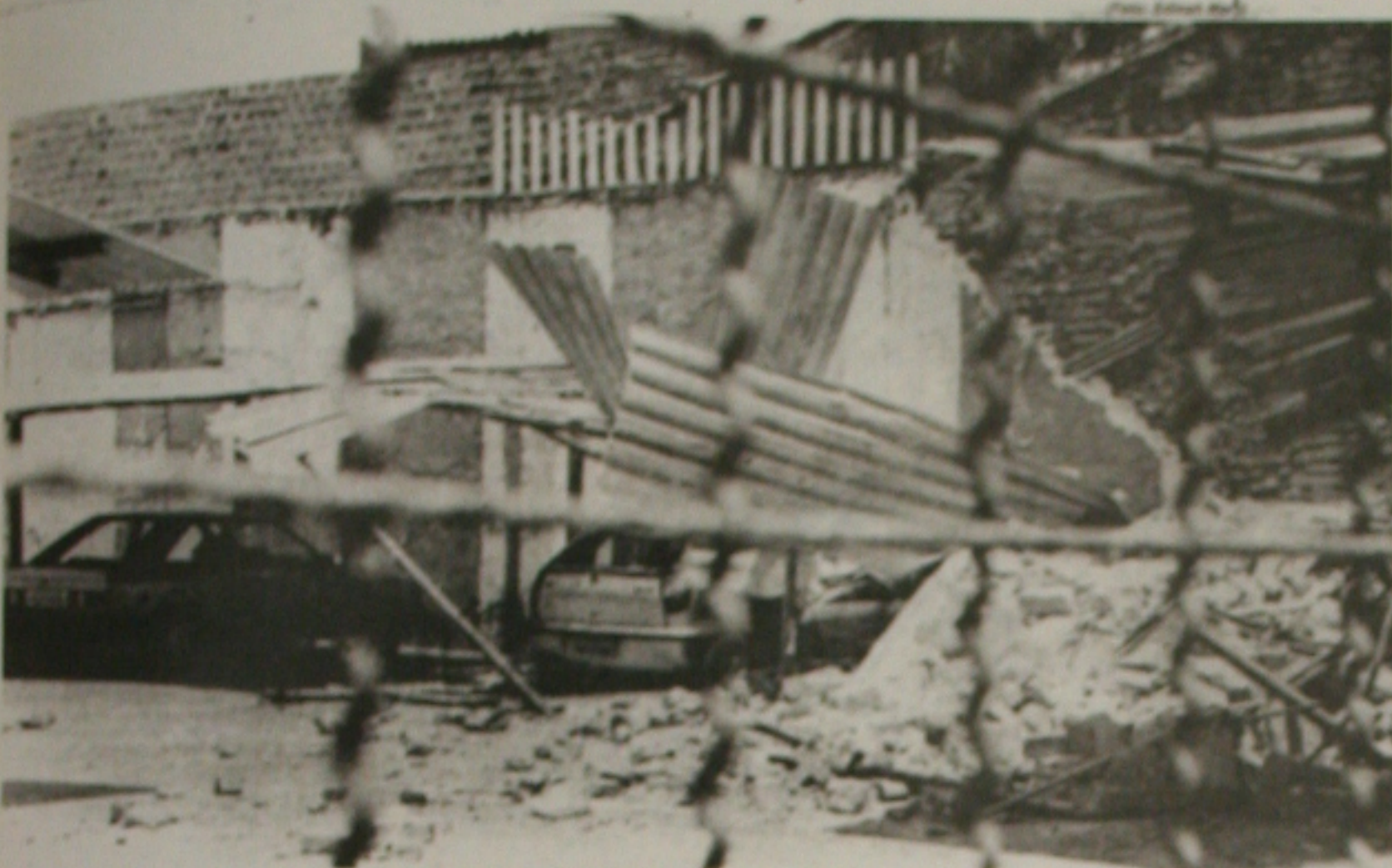
Parede de estacionamento desaba danificando quatro veículos e ainda causou ferimentos em um funcionário
