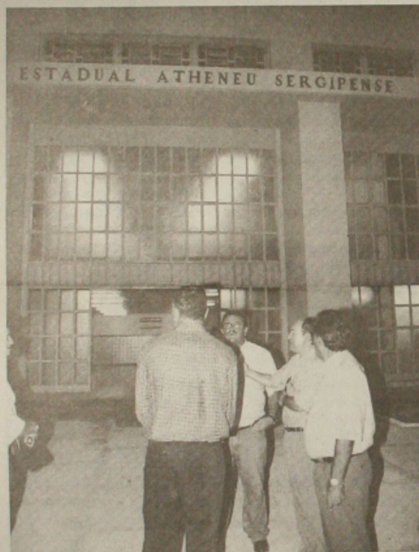
Secretário e diretor da Cehop vão ver de perto as obras de recuperação do Atheneu.
