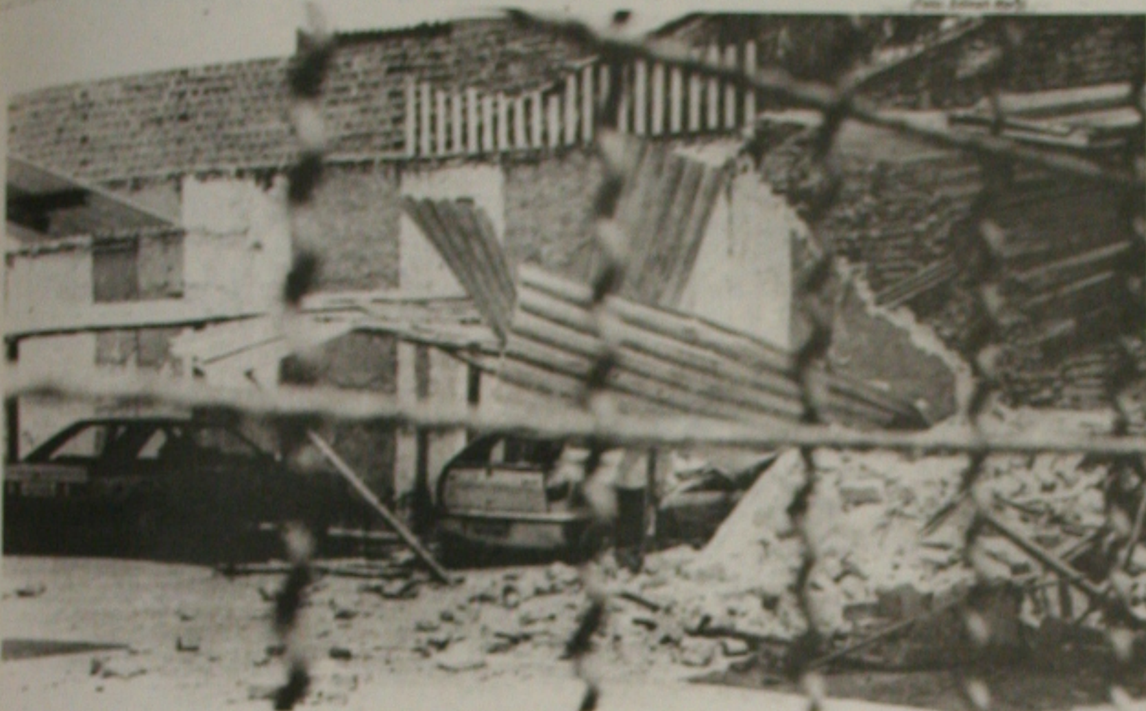
Parede de estacionamento desaba danificando quatro veículos e ainda causou ferimentos em um funcionário
