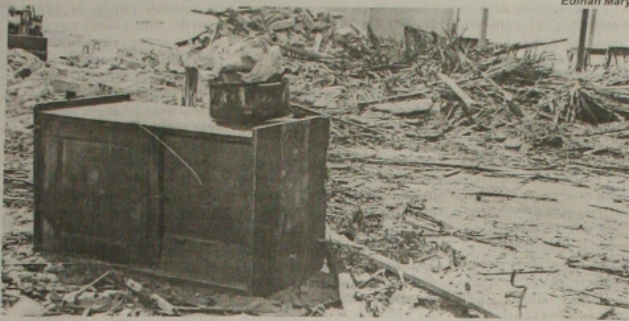
Com a nova demolição, subiu para três o número de bares já derrubados este ano na Aruana
