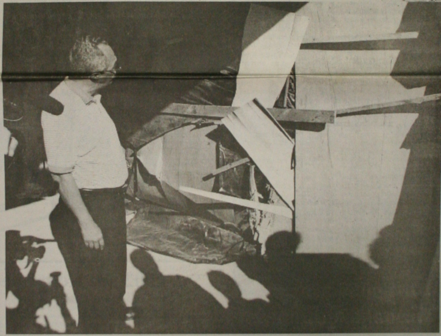
No hospital, João constatou que o almoxarifado funciona improvisado com tapumes e plásticos.
