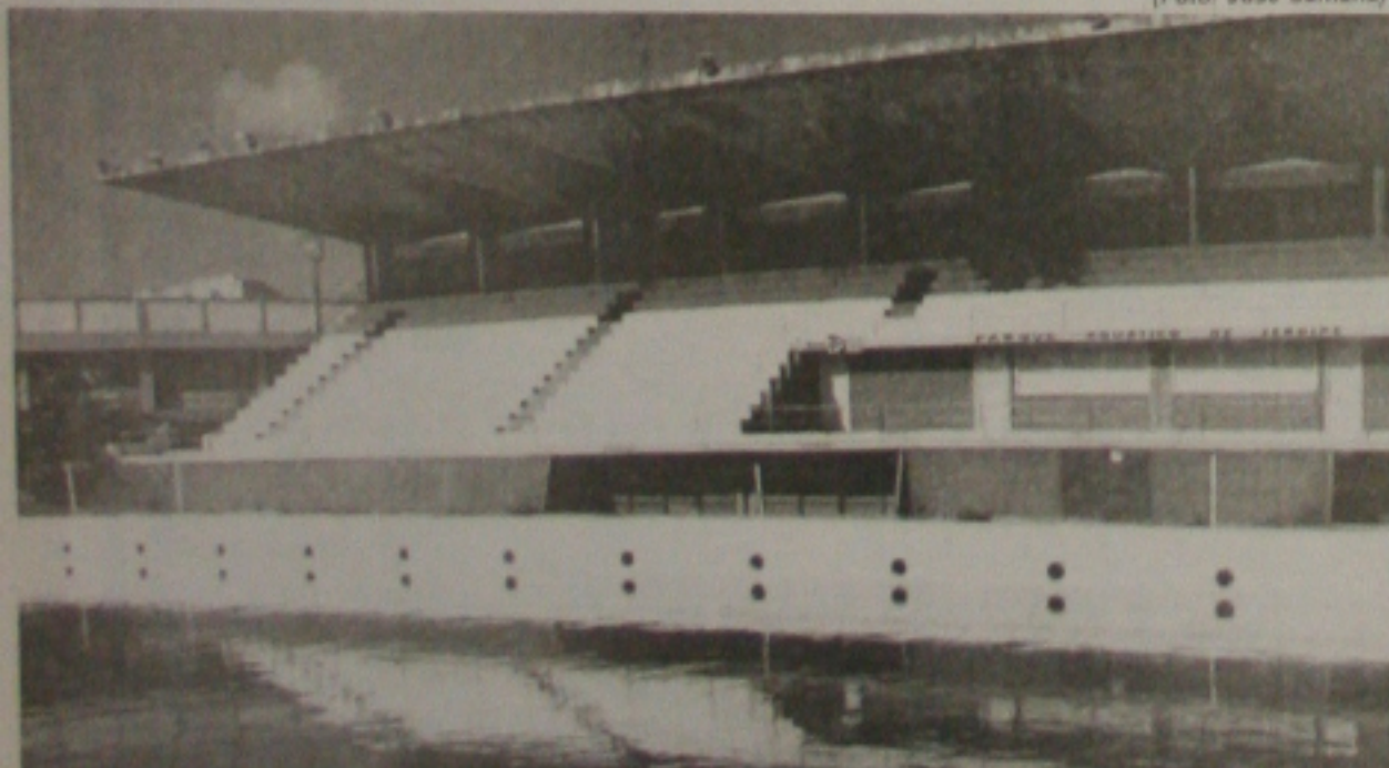
O governador João Alves classificou ontem como "terra arrasada" o estado de deterioração do Parque Aquático de Sergipe (foto), no Batisão. "É lastimável", indignou-se, diante do abandono do complexo de piscinas semi-olímpicas. O Parque Aquático está destruído. Nada ficou de pé. As duas piscinas se transformaram em um poço de água escura e fétida. A marquise da arquibancada apresenta infiltrações por toda parte. Os vestiários masculino e feminino estão irreconhecíveis: armários quebrados, banheiros no chão e bancos repartidos em mil. "O aspecto é de terra arrasada com riscos para a saúde pública", diagnosticou o governador.
