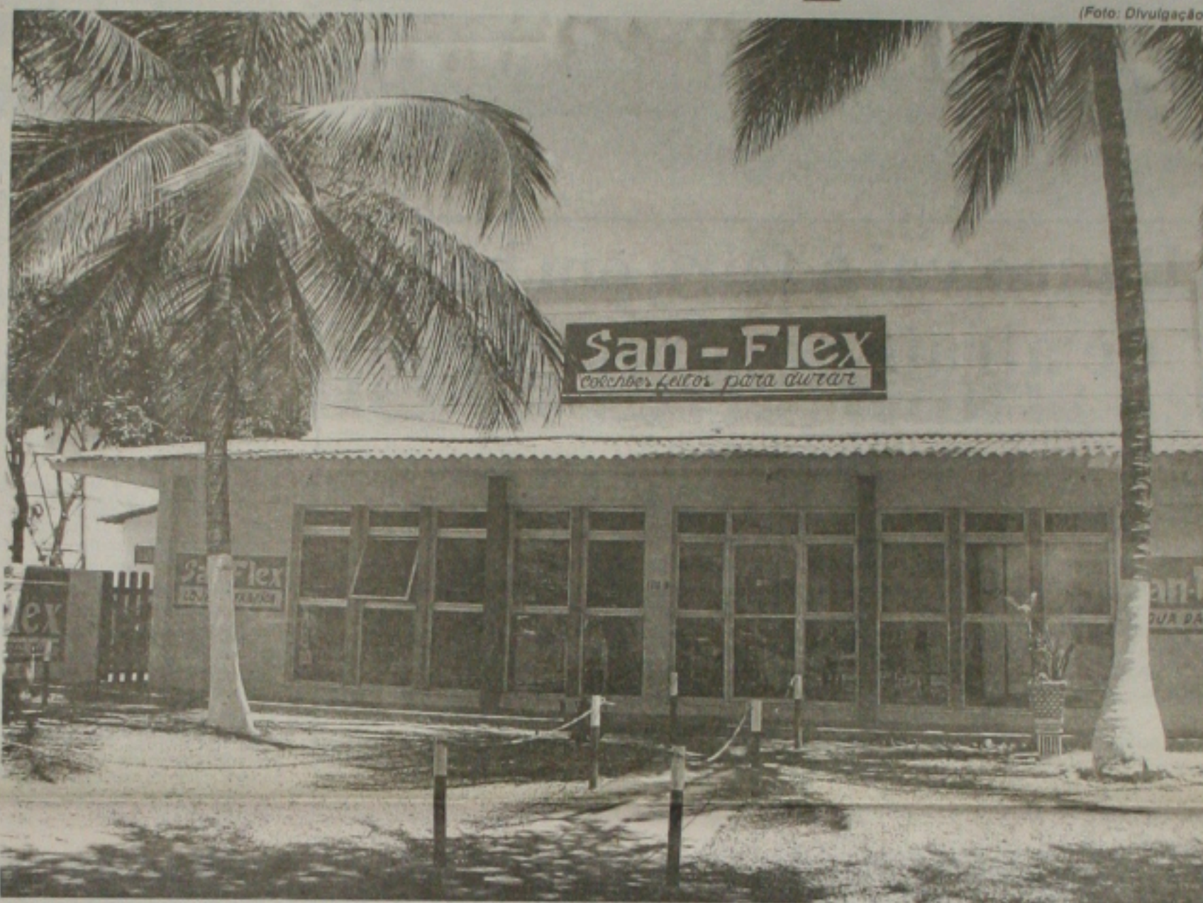
Um provável curto-circuito deve ter sido a causa que destruiu parte da fábrica de colchões, no DIA
