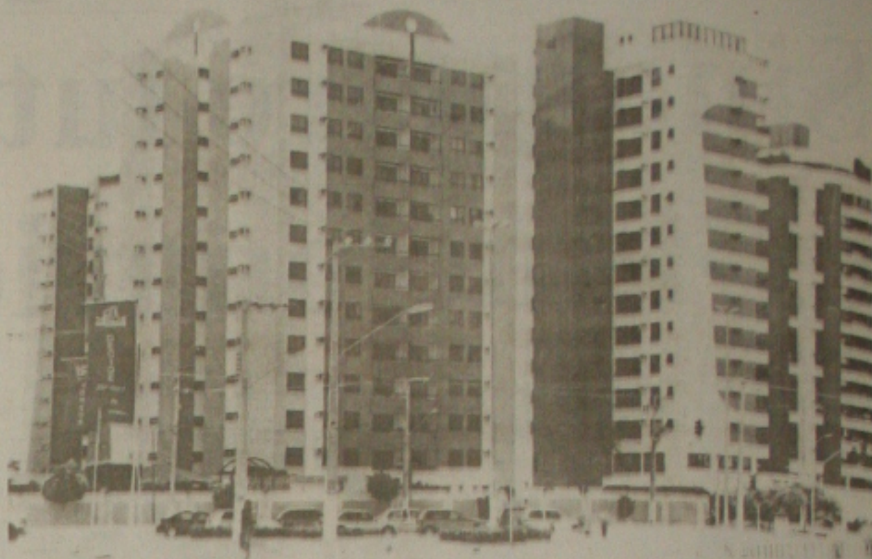
Figueiredo diz que vistorias os prédios de Aracaju com regularidades para evitar tragédia
